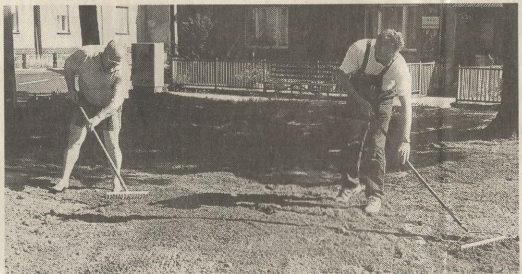
Auf der Dorfau wurde die letzte Erde verteilt. Später soll hier Rasen gesät werden. Text u. Foto: Ross
