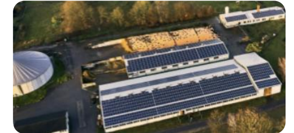
Dachflächen-Solaranlage "Groß Warnow"
